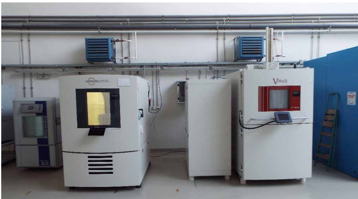
klimatická a teplotní a šoková komora
