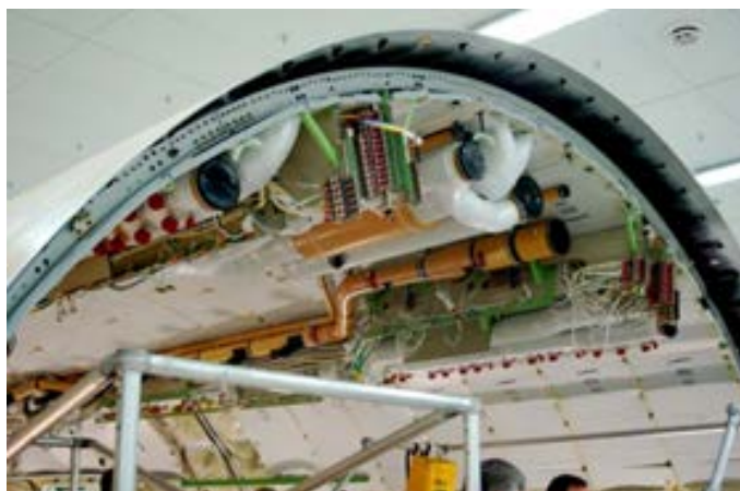
Obrázek 1 Rozvody vzduchu klimatizace ve velkém dopravním letadle
