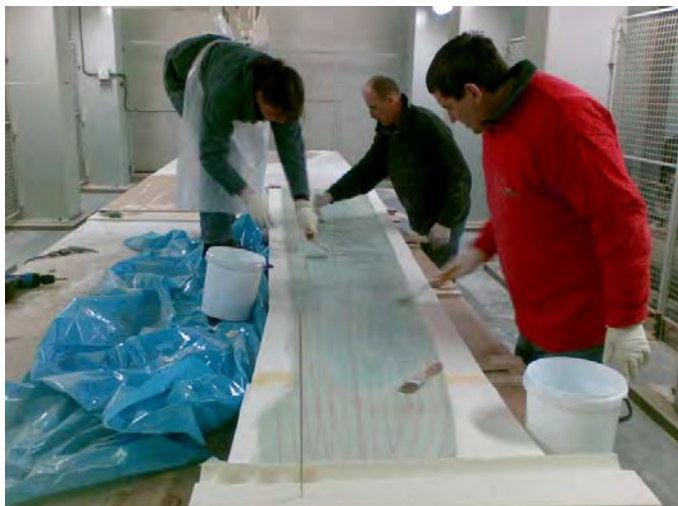
Obr. 4 Laminování spodního potahu do negativní formy
